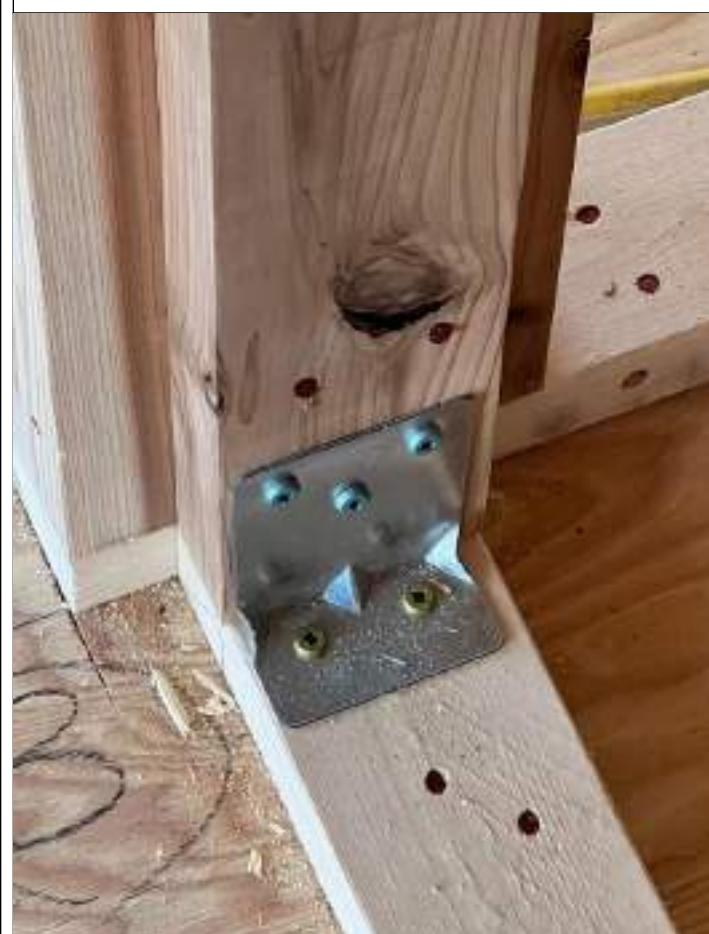
1-13 □接合金物の種類・施工位置が図面通りか確認する。(4/4)
