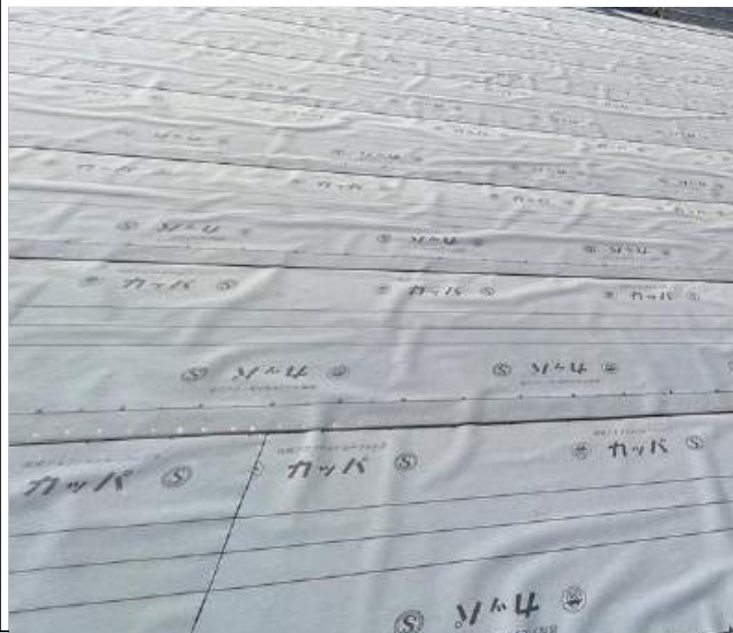
1-23 屋根ルーフィングの立ち上がり250mm以上確保し、上端は気密テープで圧着する。かつ雨押さえ上端より50mm以上とする
