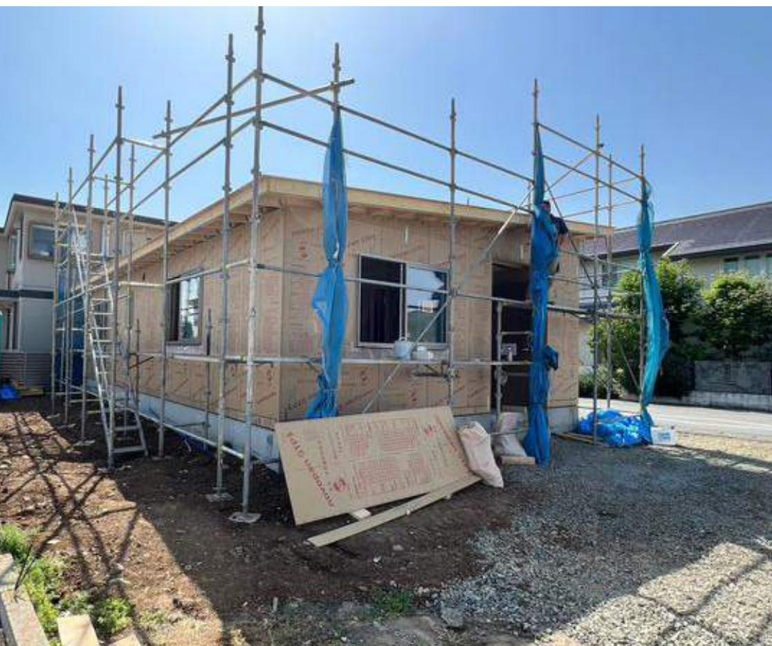
1-10 □外壁下張りの釘のピッチはメーカー仕様の壁倍率通りに施工する。(2/
