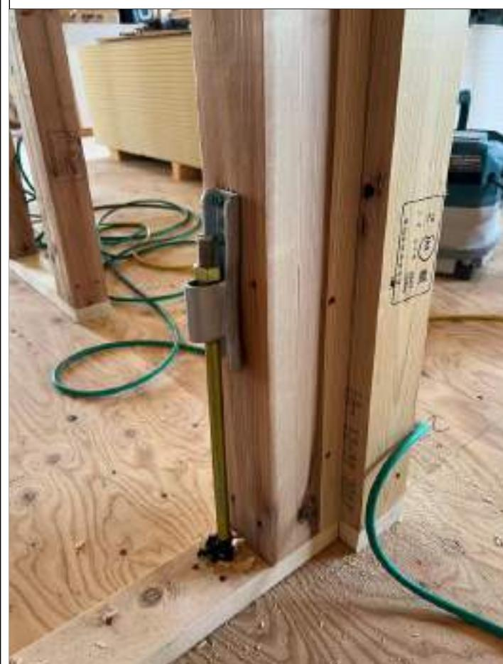
1-13□接合金物の種類・施工位置が図面通りか確認する。(2/4)
