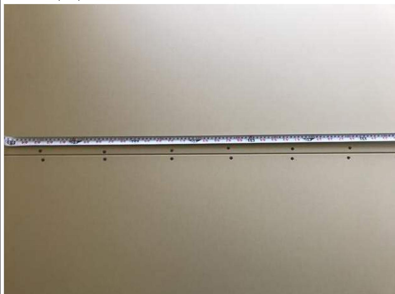
1-15 くぎ打ち間隔は外周100mm以内、中間部200mm以内の間隔で留め付ける。(2枚張りの場合) くぎ打ち間隔は外周部及び中間部とも200mm以内とする。(2/2)
