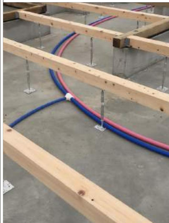
1-13 □接合金物の種類・施工位置が図面通りか確認する。(1/4)
