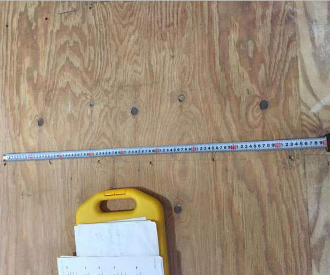
1-10□外壁下張りの釘のピッチはメーカー仕様の壁倍率通りに施工する。(1/2)
