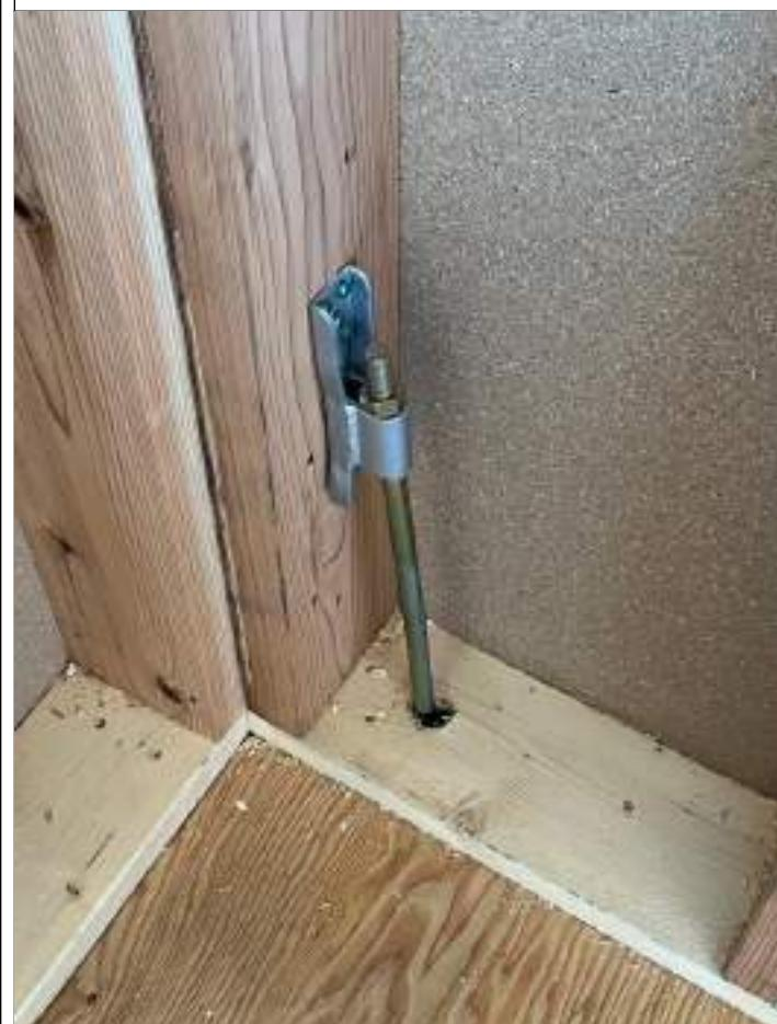
1-13□接合金物の種類・施工位置が図面通りか確認する。(3/4)
