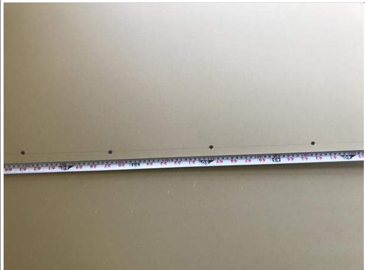
1-16 壁張りに用いるせっこうボードは、床面からの湿気により強度が低下しないように床面から13mm程度離して打ち付ける
